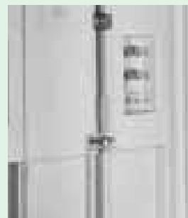
Отвернутый центральный винт для пломбы
