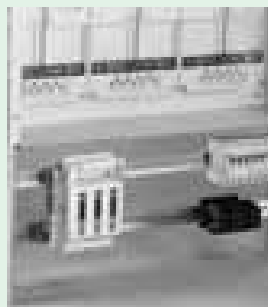
Вставление отделяющей перегородки ZTW (составная часть корпуса ZWN)
