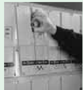
Выдвижение и задвижение панели электрических счетчиков ZBR
