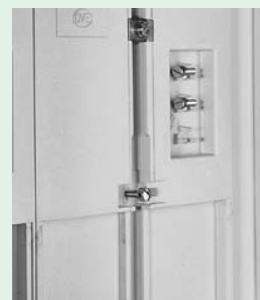
Отвернутый центральный винт для пломбы
